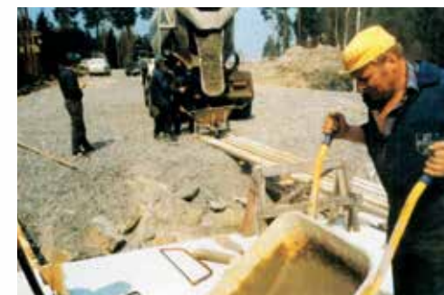
Arbete vid tunnelbygget på Centrumvägen. Bilden är från boken Smedsby 1940-2002
